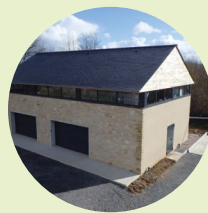
usine du SIAEP d'Evran (22), France 100 m 3 /h
