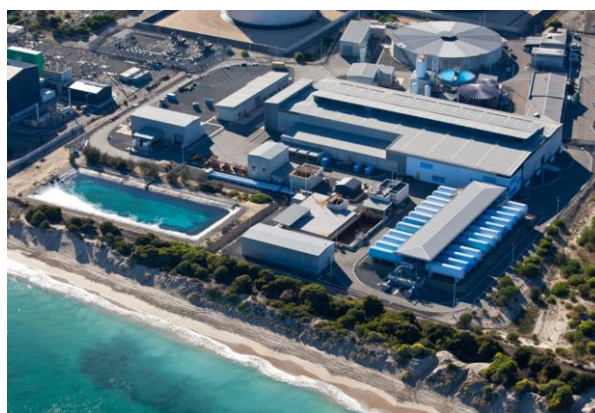
Usine de dessalement d'eau de mer, à Perth (Australie) – © SUEZ
