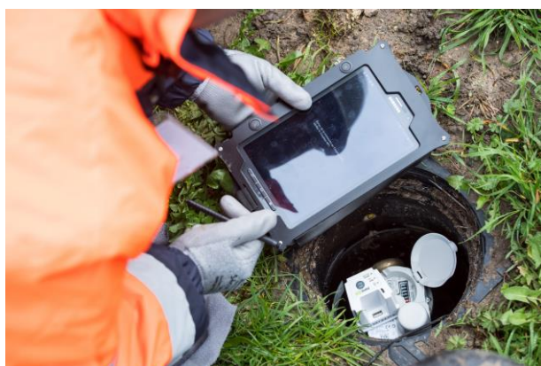
Installation d'un compteur communicant - © SUEZ
