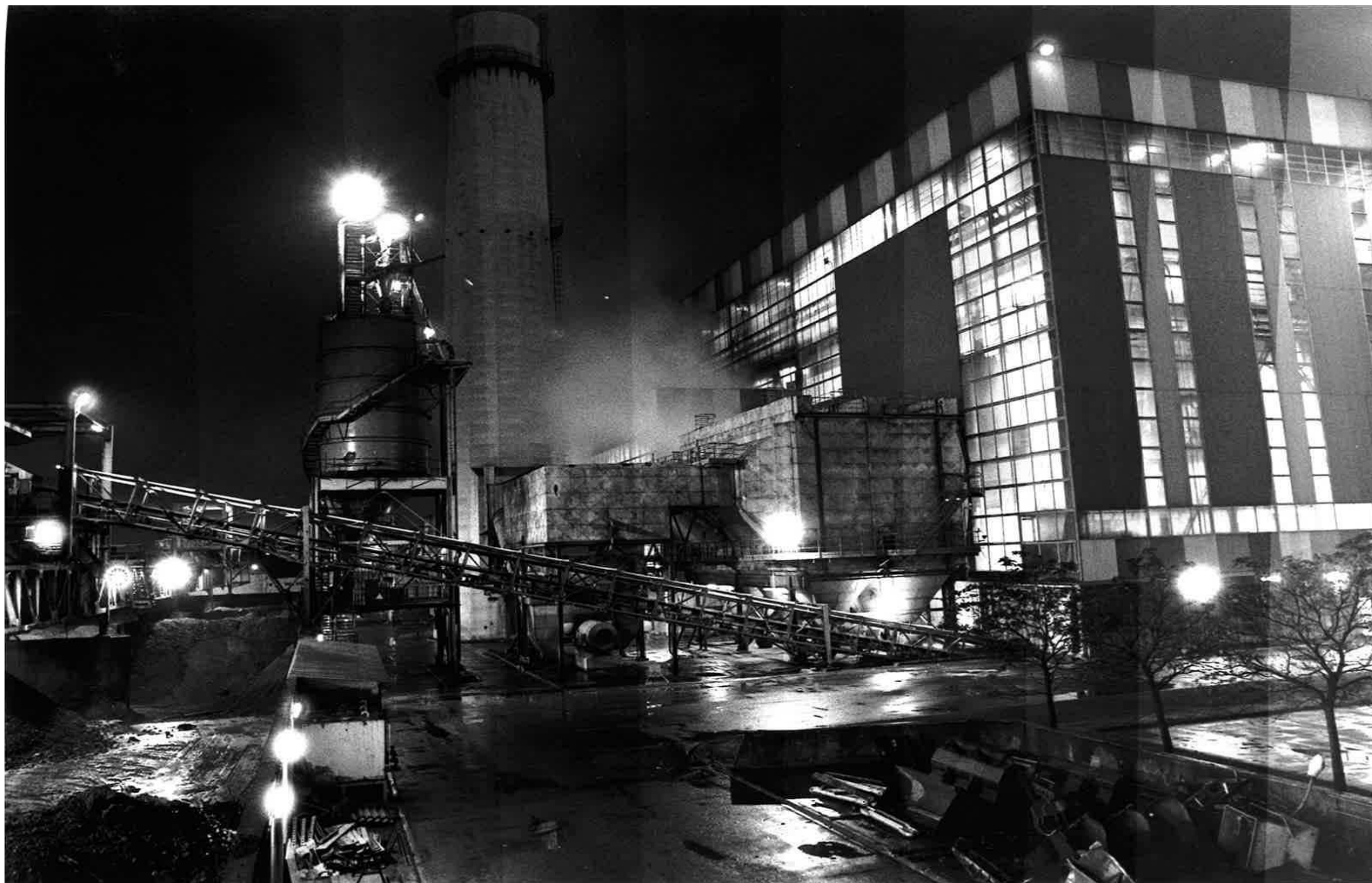
Usine d'Ivry sur Seine avant 1995
