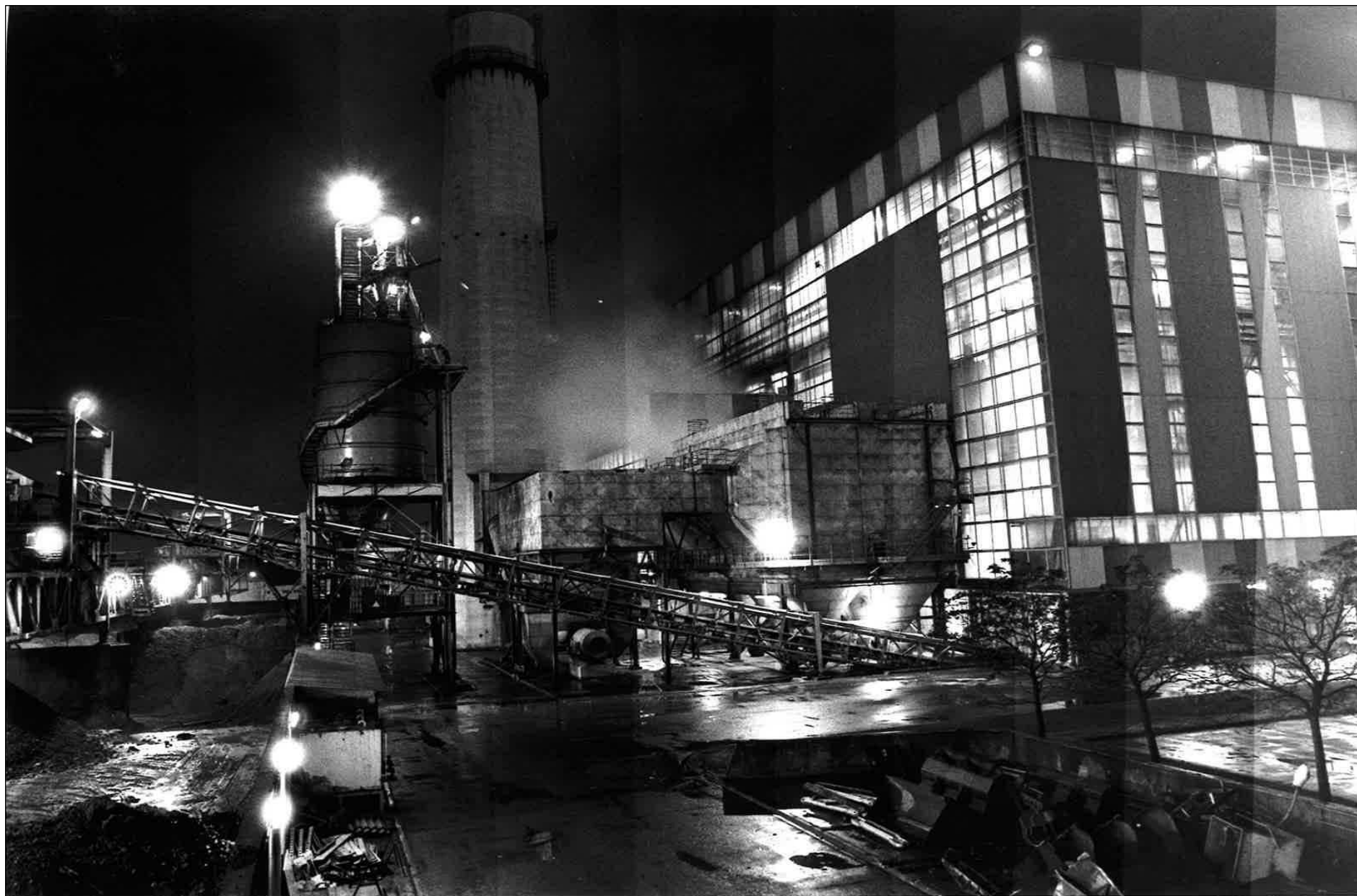
Usine d'Ivry sur Seine avant 1995
