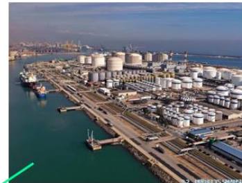
Tanques para AFs verdes
