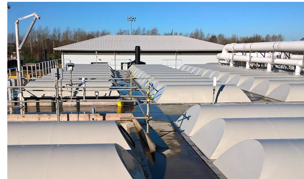
Cubiertas rígidas en EDAR
