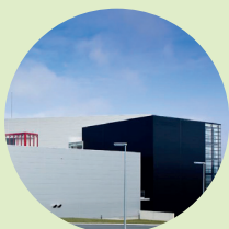
usine de Stembert - la Gileppe, Belgique 2 500 m 3 /h
